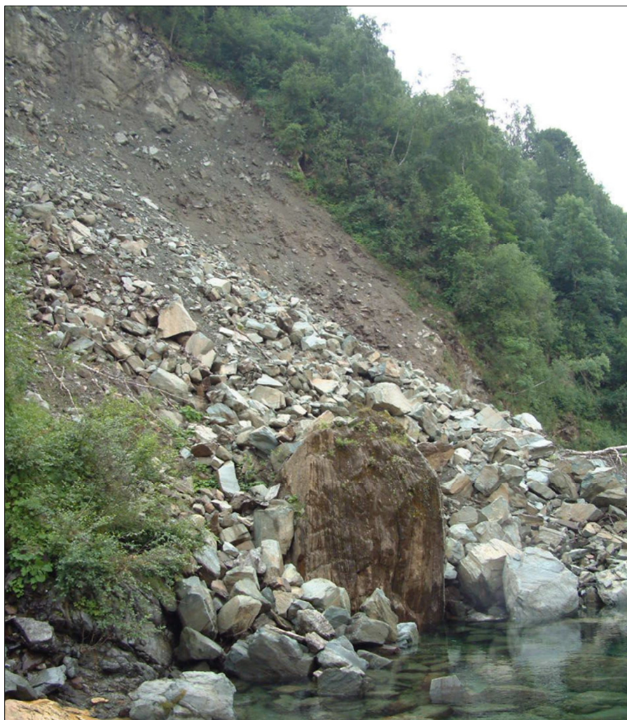
Fig. 3.2 – Frana di crollo per erosione al piede da parte del T. Ribordone nel tratto prospiciente la Frazione di Talosio (data della ripresa 2003)
